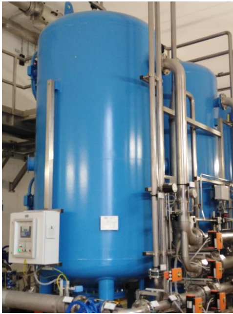
Abb 5: Entmanganungsfilter
