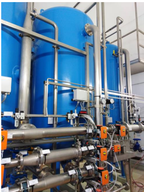
Abb 3: EnteisungsfILTER
